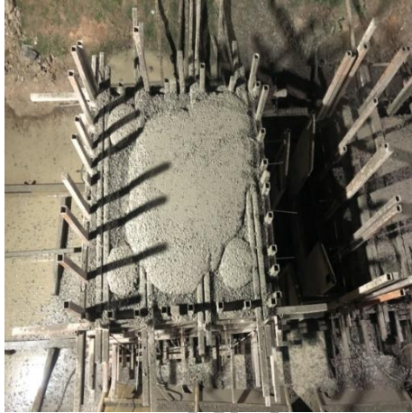
图7 1:1 试件浇筑完成的情况
